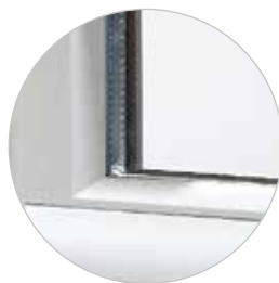
Ouvrant extérieur type "solin mastic à l'huile de lin"
