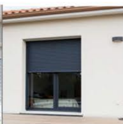
Coffre tunnel ou demi-linteau
