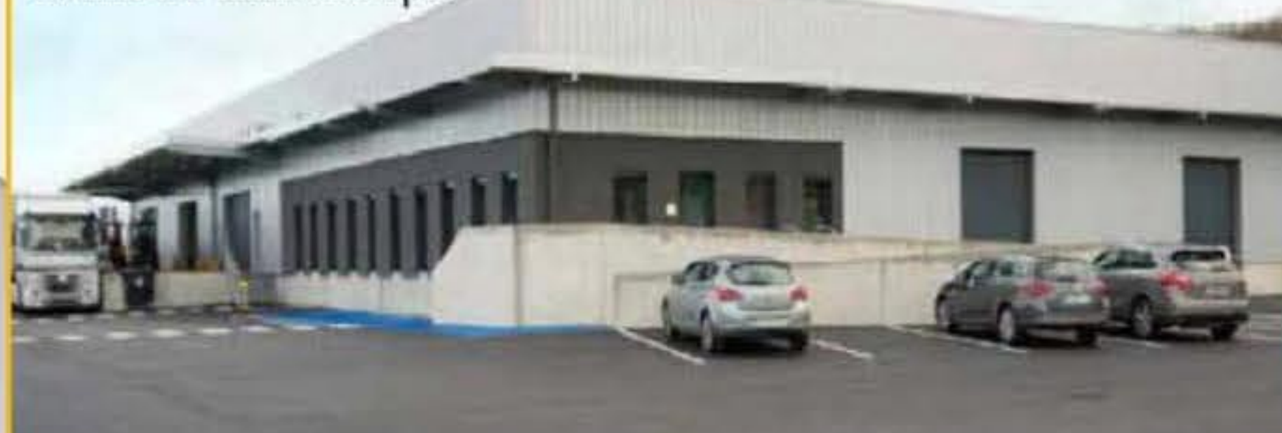
Usine de Saint Loup 2
