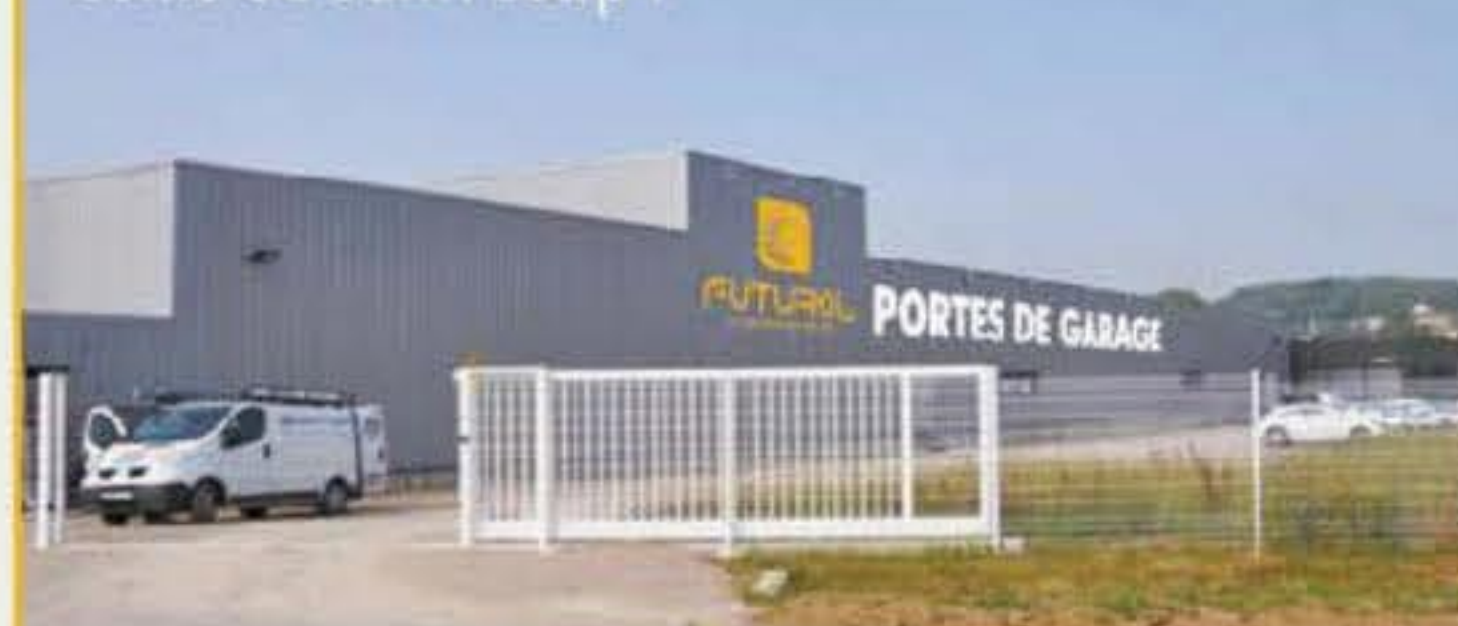
Usine de Saint Loup 1
