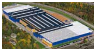
Hörmann KG Eckelhausen, Allemagne
