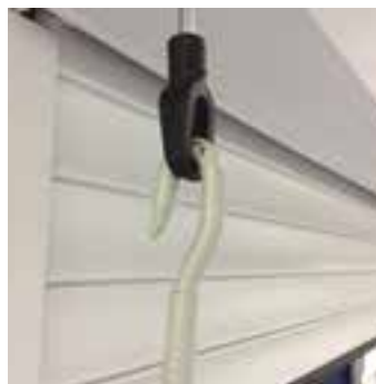
Manceuvre manuelle de dépannage intérieure.
