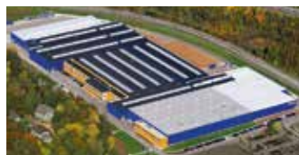
Hörmann KG Eckelhausen, Allemagne
