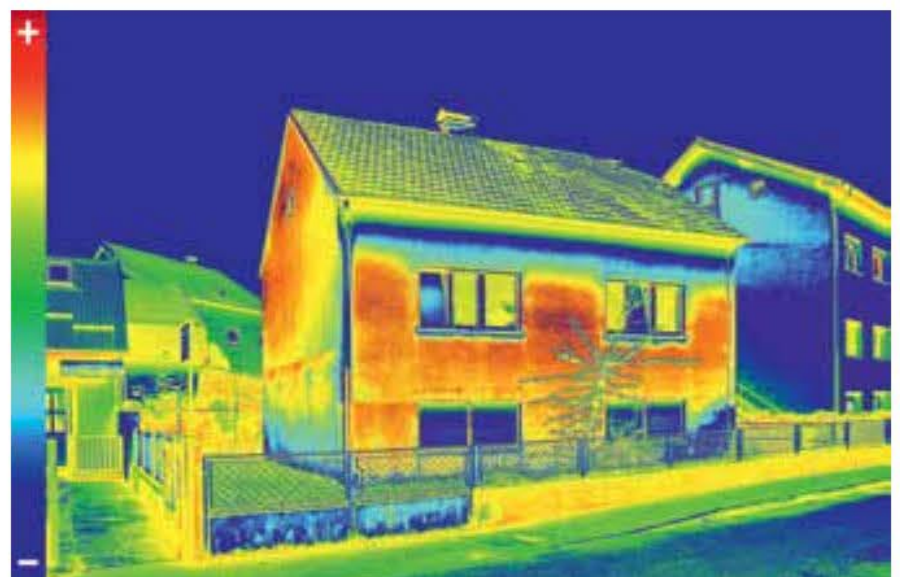
Relevé thermographique d'une maison
